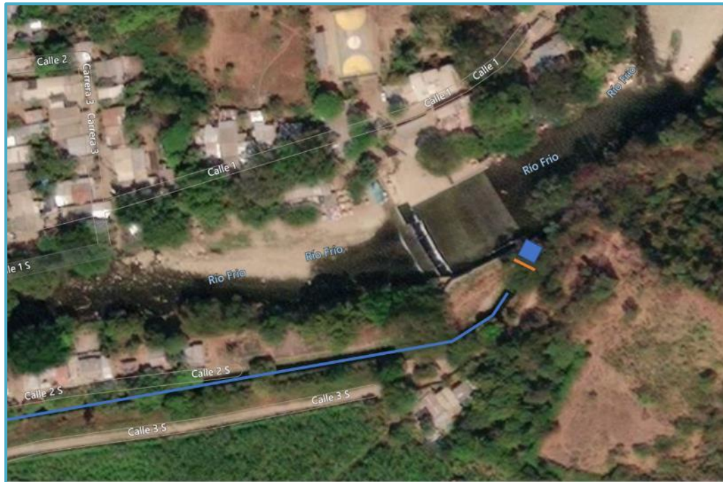
Figura 4-3. El Río Frio, a la altura del pueblo Río Frio, y las infraestructuras primarias de agua de ASORÍOFRIO, con la toma principal (cuadrado azul), la estructura del vertedero (línea naranja), y el canal Santa Inés (línea azul), en zoom inferior, Bing maps Imagery.
